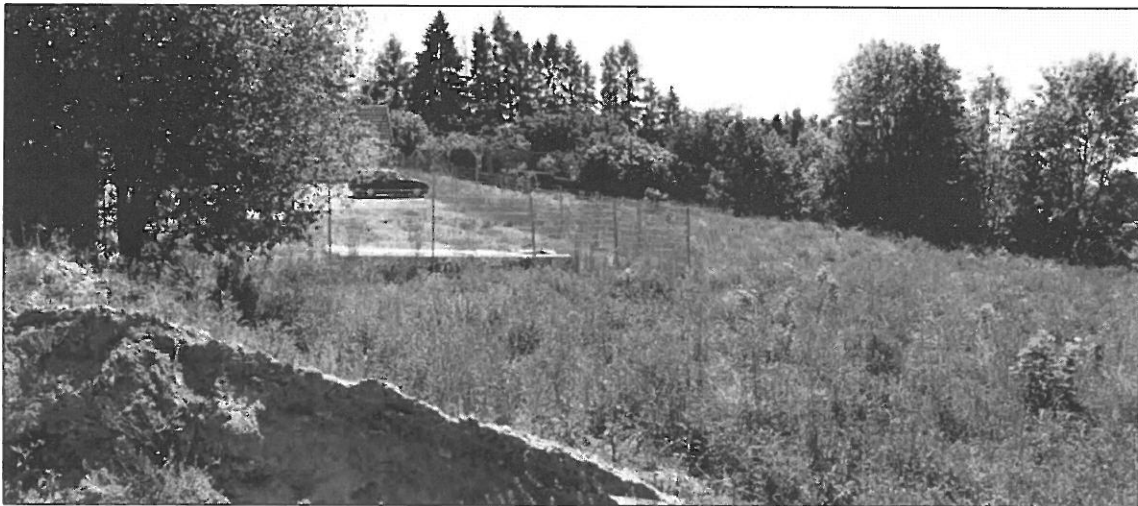
Abbildung 7: Blick von der straßenparallelen Baustelle Richtung Autoscheune. Foto: Stadt Land Fluss 25.05.2012.
