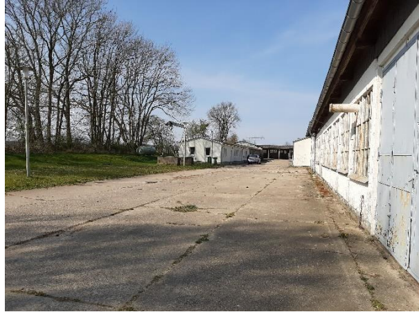
Bestandsgebäude und Baumreihe am südlichen Rand des Geltungsbereiches
