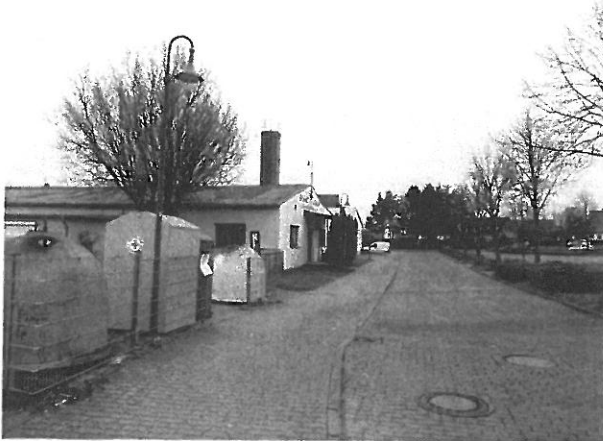
Blick in Richtung Süden auf das rückzubauende Gebäude des ehemaligen Jugendklubs. Rechts befindet sich der Marktplatz.
