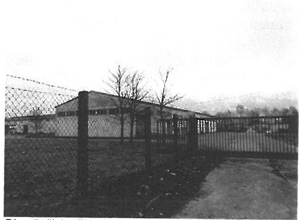
Die nördliche Plangebietsgrenze in Richtung Osten.
