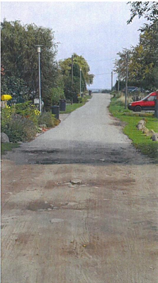
Die Bauleistungen umfassen den Um- und Ausbau der Verkehrsflächen in Anlehnung an die Richtlinien für den ländlichen Wegebau (RLW 99) einschließlich der Herstellung von Anlagen zur Entwässerung. Es handelt sich bei dem Bauvorhaben um einen einstreifigen Verbindungsweg. Im Zuge der Baumaßnahme ist die vorhandene Buswendeschleife mit auszubauen.
