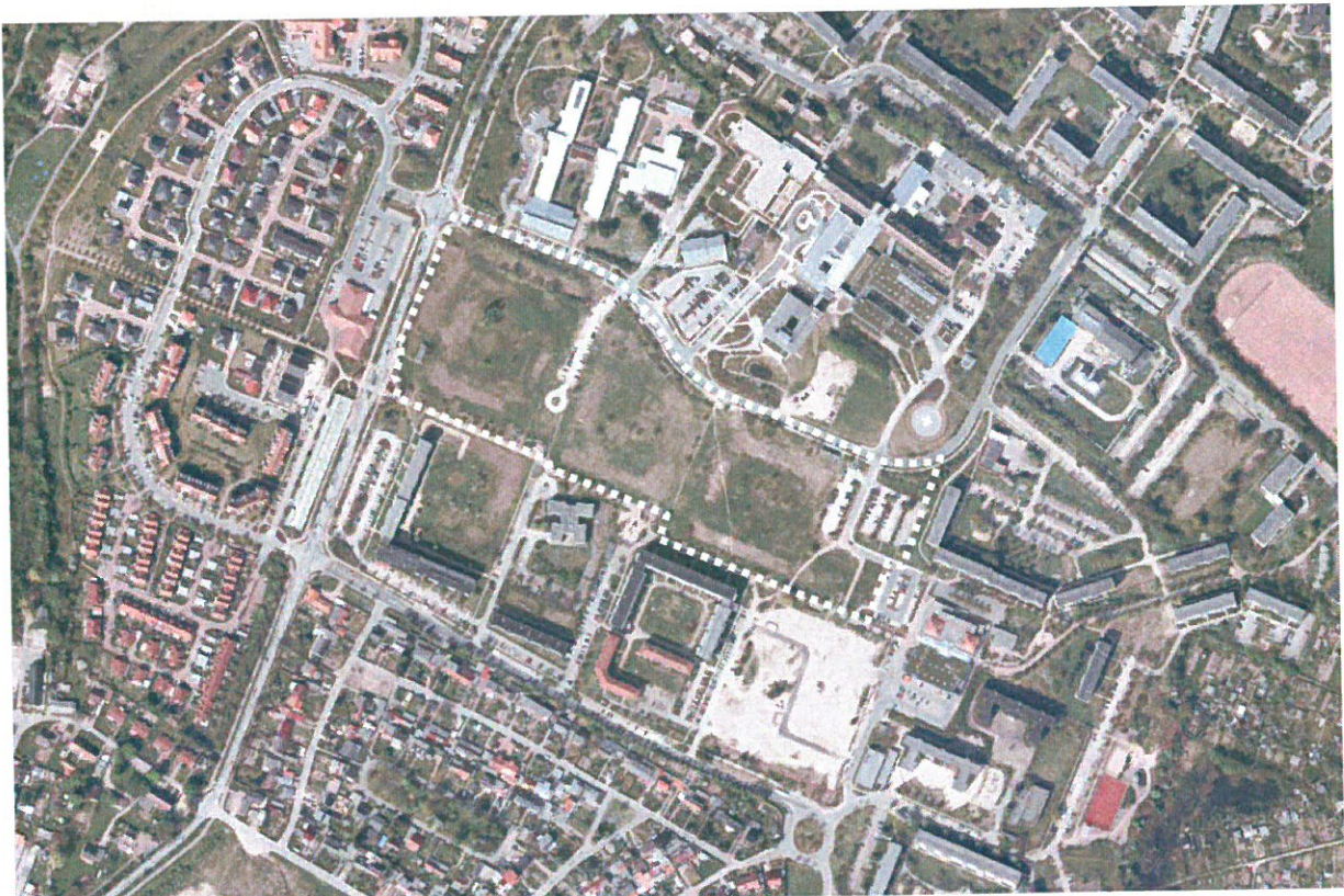
Luftbild des Plangebietes (Quelle: GeoBasis DE/M-V 2015)
