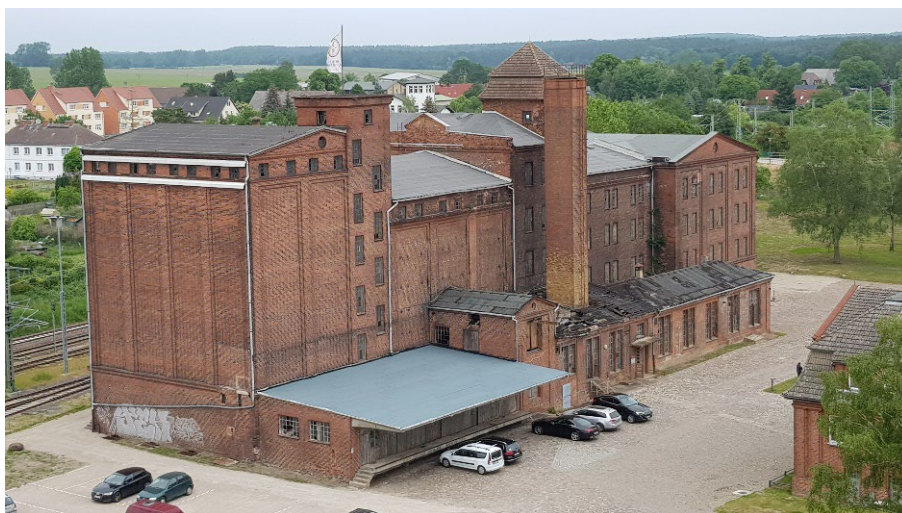
Abbildung 10: Blick vom Kornspeicher, dem höchsten Gebäude des Orts, auf das Mühlengebäude
