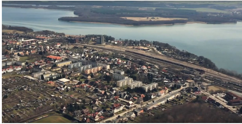
Abbildung 11: Luftbild aus Handrick 2013. Gut zur erkennen sind hier die Plattenbaugebiete, das Mühlenengelände mit den höchsten Gebäuden sowie die Fragmentierung durch die Bahn hin zum See.
