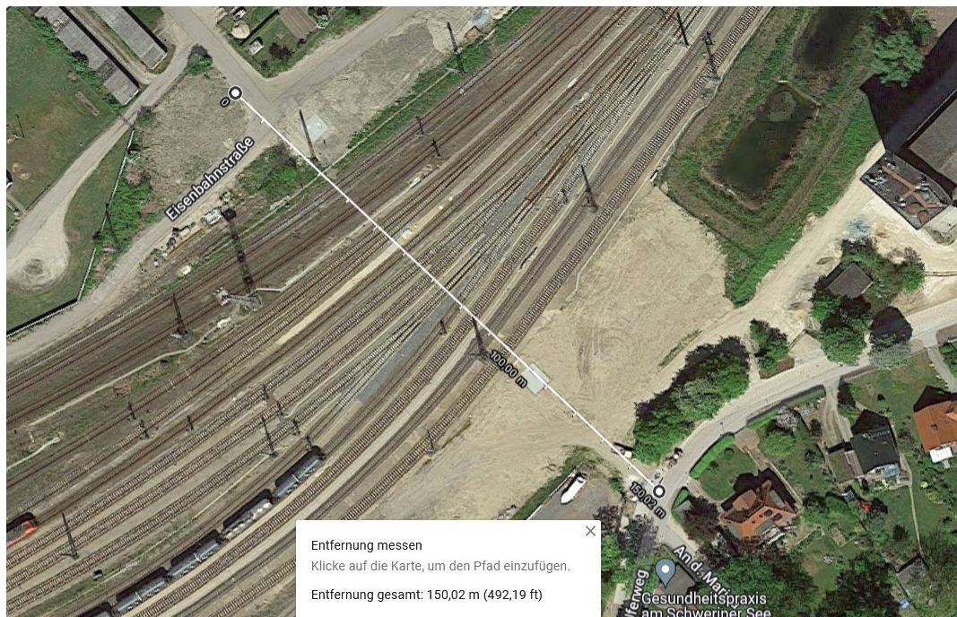
Abbildung 39: Brückenlänge 1 gemäß Luftbild Google Maps.
