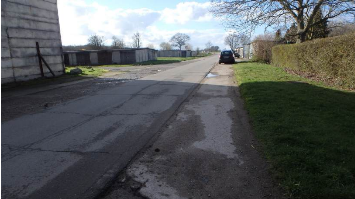
Abbildung 12: Garagenkomplex westlich des Plangebietes mit teil- und vollversiegelten Wirtschaftswegen (März 2024)
