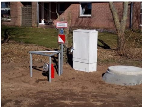
Abbildung 23 Löschwasserbrunnen mit Tiefpumpe
