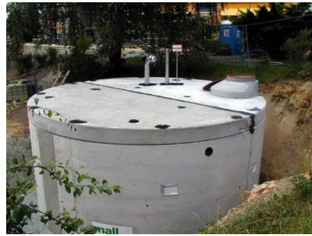
Abbildung 22 Unterirdischer Löschwasserbehälter
