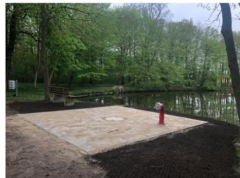
Abbildung 26 Entnahmestelle am offenen Gewässer
