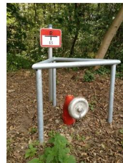
Abbildung 24 Löschwasserbrunnen ohne Tiefpumpe
