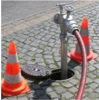
Abbildung 21 Unterflurhydrant mit Standrohr
