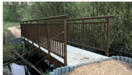
Freitragend bauen wir in GFK-Trägerbauweise bis 14m Spannweite, und in Fachwerkbauweise rein GFK bis 30m. Hierbei werden grundsätzlich immer 5kN (500kg) pro m<sup>2</sup> Gesamtlast und 10kN (1 to.) Punktlast erfüllt. Unsere GFK Brücken sind in jeder Farbe lieferbar.
