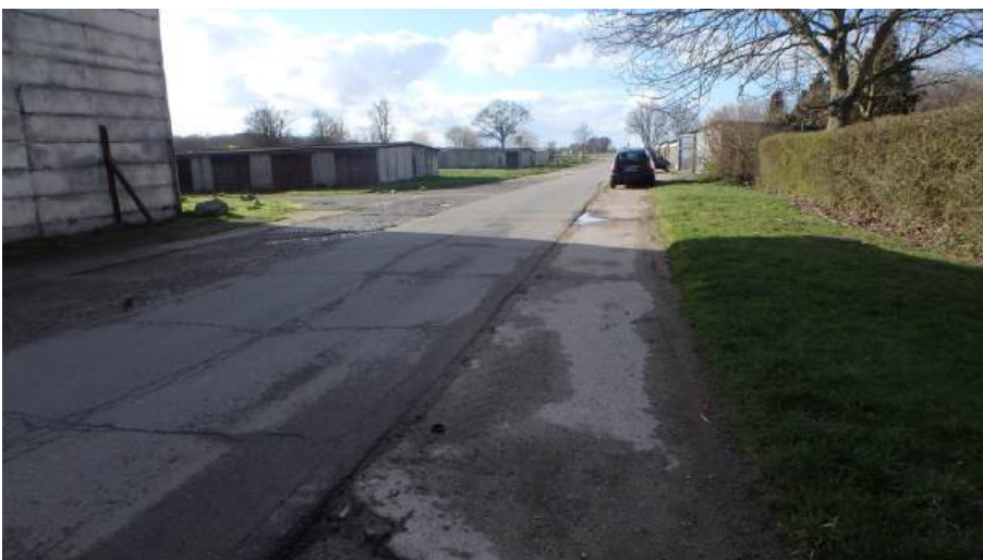
Abbildung 12: Garagenkomplex westlich des Plangebietes mit teil- und vollversiegelten Wirtschaftswegen (März 2024)
