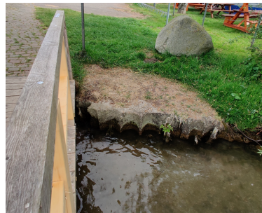
Uferbefestigung neben dem Bootssteg
