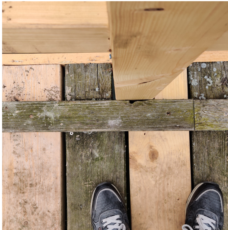
Blick auf Fußleiste und ausgetauschte Bauteilen
