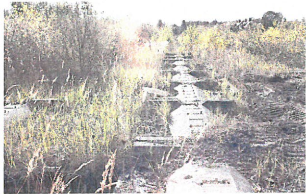
Bestandssituation im Plangebiet vor Beräumung
