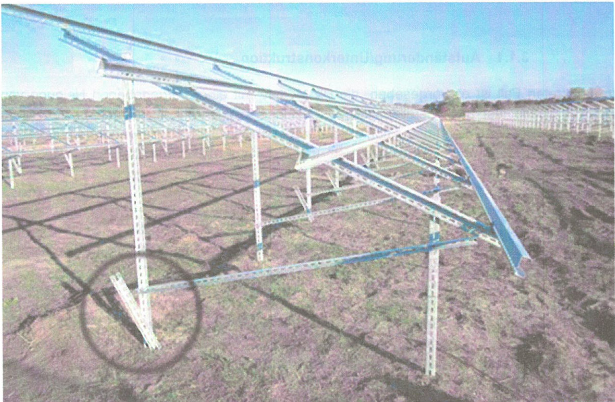
Abbildung 6: Schrägrammung zur Stabilisierung (Quelle PUK-Solar)
