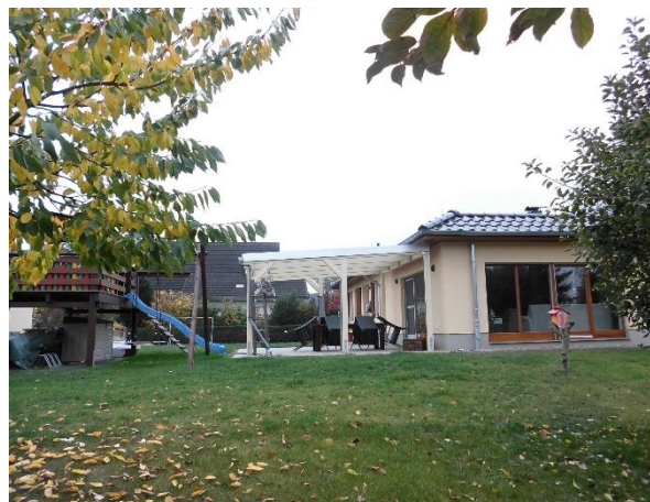
Terrasse mit Gebäudeerweiterung
