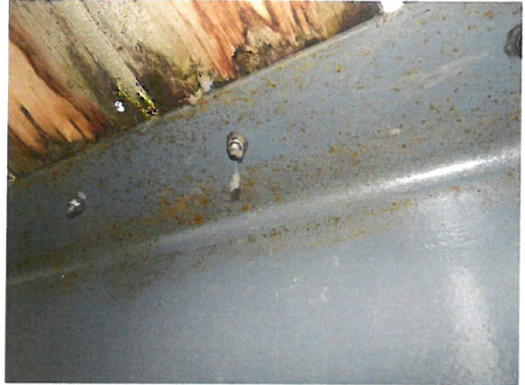
DMBK_18_0_2019H_LT-2 MITTIG UNTERROSTUNGEN
