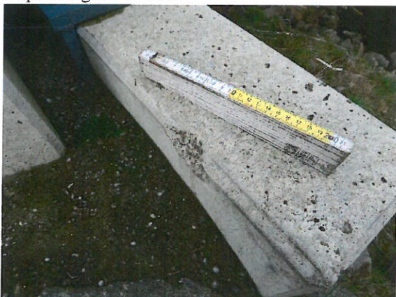
DMBK_18_0_2019H_WL-H LINKS ABPLATZUNG
