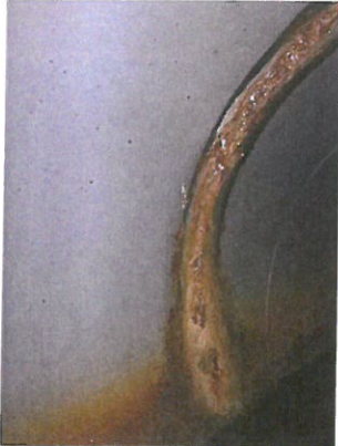
DMBK_19_0_2019H_2 STOß HINT KÄMPFERBEREICH BIS SCHEITEL AS NASS
