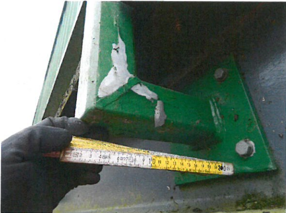
DMBK_18_0_2019H_R-GEL PF-3 UNTEN BESCHICHTUNG ABGEBLÄTTERT
