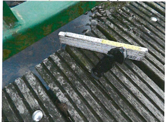
DMBK_18_0_2019H_BOHLE MITTIG LINKS GESPALTEN
