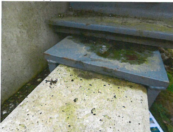
DMBK_18_0_2019H_LAG-3 WL-V U-LAGERPLATTE UNTERROSTUNGEN
