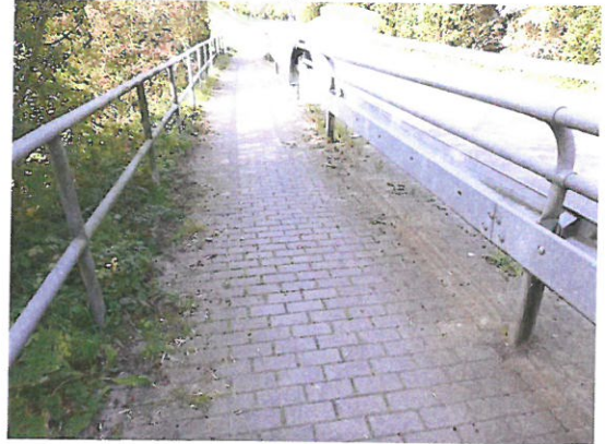
DMBK_19_0_2019H_LI GEHWEG PFLASTER M BEWUCHS
