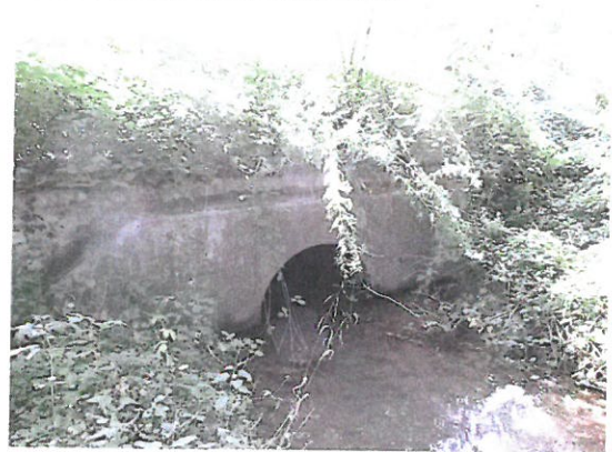
DMBK_19_0_2019H_SEITENANSICHT UNTERWASSER LICHT E HÖHE
