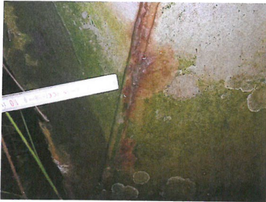
DMBK_19_0_2019H_ ROST AN DIAGONALSCHWEIßNAHT
