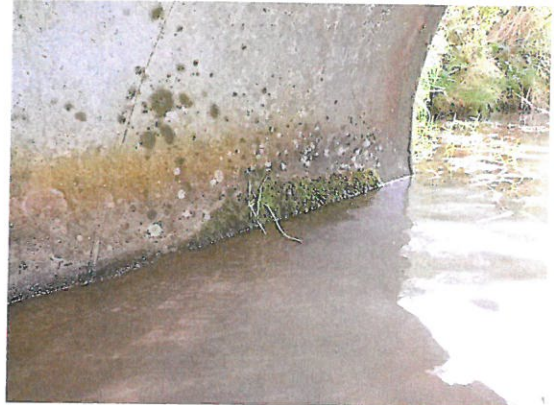
DMBK_19_0_2019H_ EINLAUFSEITE VORD KÄMPFER MIT MOOS
