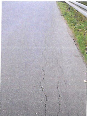
BW-19_0_2016E_LR FAHRBAHN RE WALZASPHALT
