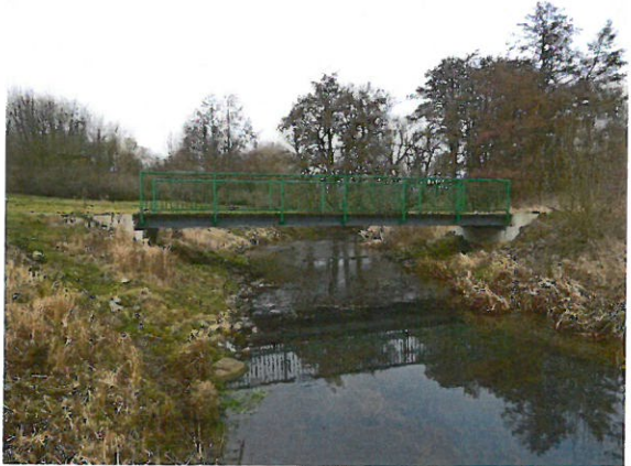
DMBK_18_0_2019H_BÖSCHUNGSTREPPE FEHLT
