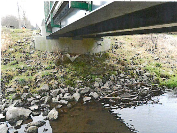
DMBK_18_0_2019H_BÖSCHUNG WL-H LÜCKENHAFT
