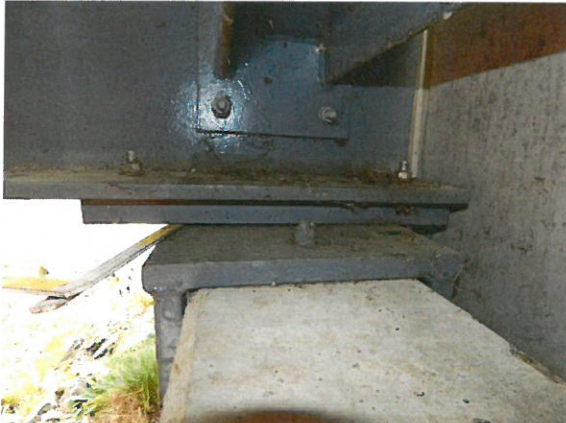
DMBK_18_0_2019H_LAG-2 WL-V LAGERSPALT
