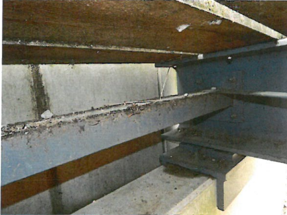
DMBK_18_0_2019H_ÜBERBAU HINTEN VERSANDUNGEN
