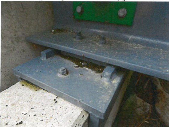
DMBK_18_0_2019H_L-LAG WL-H AUßEN VERSANDUNGEN
