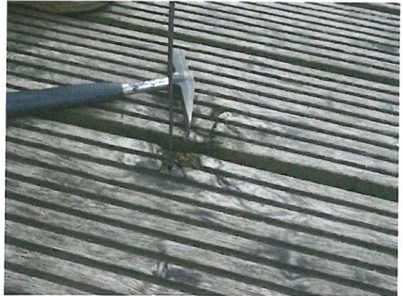
DMBK_18_0_2016E_LAUFBOHLE MIT LI ASTLOCH
