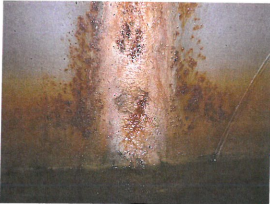
DMBK_19_0_2019H_ HINT KÄMPFERBEREICH MIT BLATTROST
