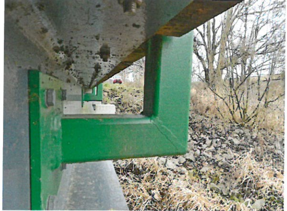
DMBK_18_0_2019H_L-GEL ENTW-ÖFFNUNG FEHLT
