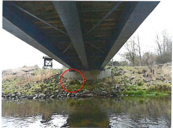
DMBK_18_0_2019H_BÖSCHUNG WL-H BEWACHSEN
