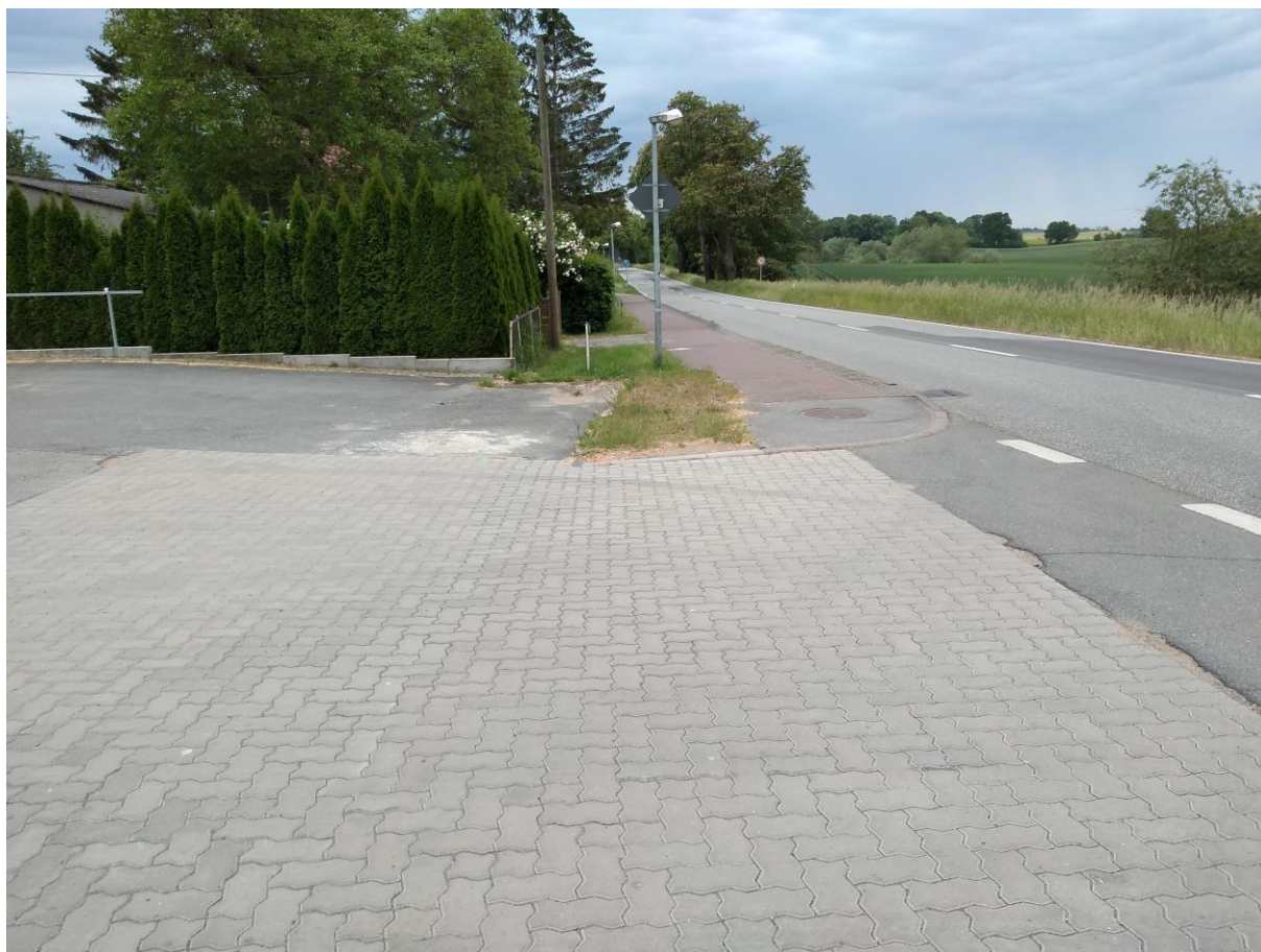
Bild 1: neu hergestellte Pflasterfläche aus Betonsteinen
