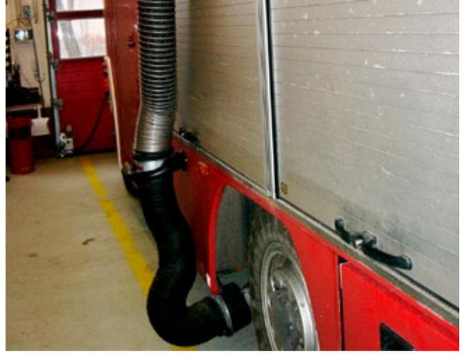
Bild 27 Regelkonform installierte Abgasabsaugung
