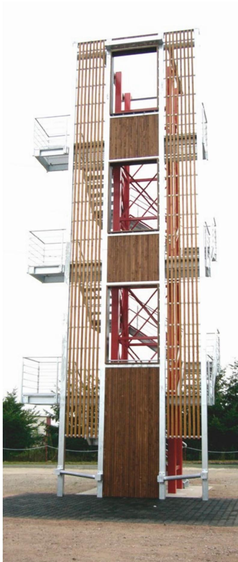
Bild 51 Übungsturm mit davor angeordnetem stoßdämpfendem Boden
