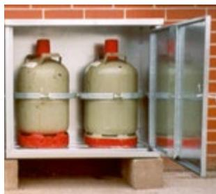
Bild 44 Kleinlager für Flüssiggasflaschen im Freien
