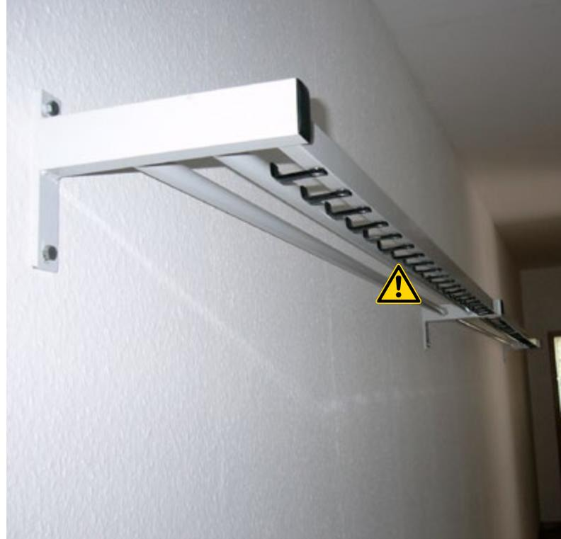
Bild 9 Garderobenhaken in Augenhöhe bilden Verletzungsgefahren
