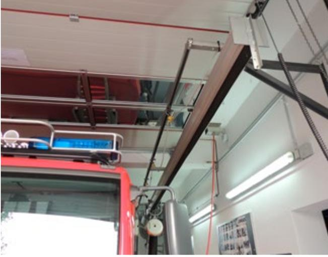
Bild 26 Führung der Laufschiene für die Abgasabsaugung unter der oberen Torhalterung
