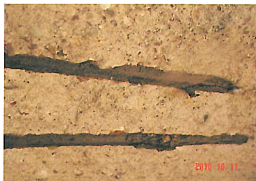
ÜBERBAUUNTERSEITE FREILIEGENDE BEWEHRUNG, GROSSFLÄCHIG
