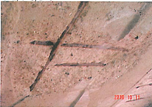
ÜBERBAUUNTERSEITE NORD FREILIEGENDE BEWEHRUNG
