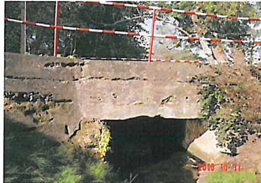
STIRNWAND BETONABPLATZUNGEN
