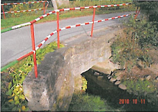
GELÄNDER VERBEULT KORROSION
