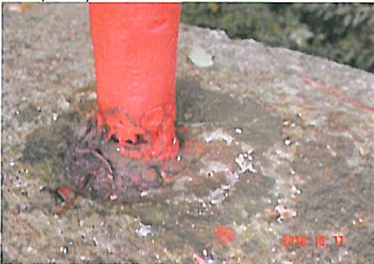
FUSSPUNKT DEFECT
