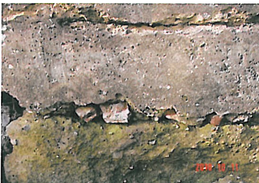
FLÜGEL MIT BETONABPLATZUNGEN
