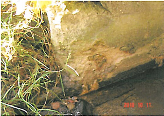
WIDERLAGER BETONAUSBRÜCHE IN WASSERWECHSELZONE
