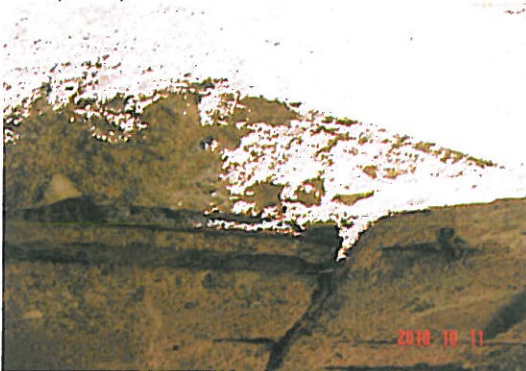
BEWEHRUNG MIT QUERSCHNITTS-MINDERUNG
