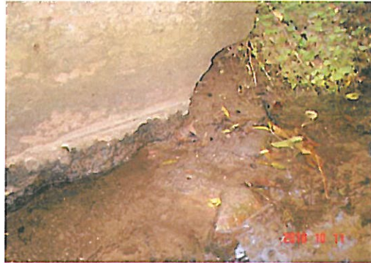
FLÜGEL SO UNTERSÜLT BETONABBRUCH
