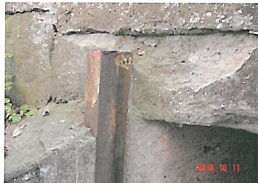
SEITENFLÄCHE ÜBERBAU SÜD BETONABPLATZUNGEN
