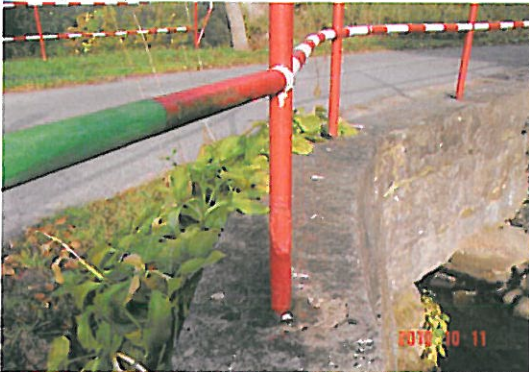
SCHRAMMBORD UND SCHUTZPLANKE FEHLEN
