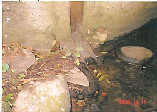
WIDERLAGER BETON AUSBRÜCHE WASSERWECHSELZONE
