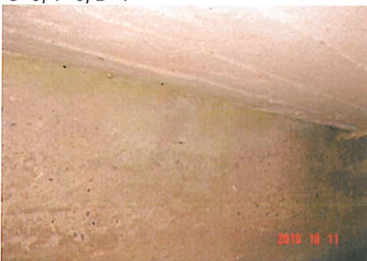
WIDERLAGER OBERFLÄCHE ABGESANDET
