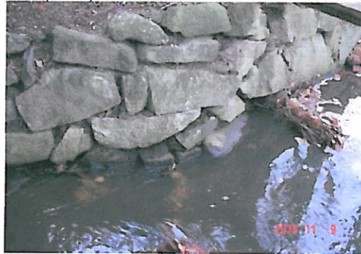
WIDERLAGERWAND AUSGESPÜLT
