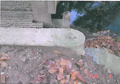
BÖSCHUNGSSICHERUNG NICHT FACHGERECHT
