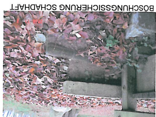
[6] Böschung im Bereich des Widerlagers, bereichsweise, abgesackt, ausgewaschen, keine Entwässerungseinrichtung vorh. S=0, V=0, D=2
