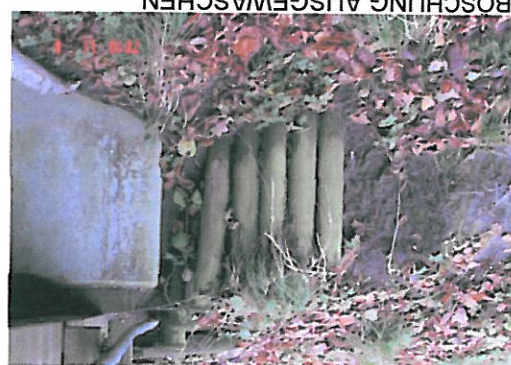
[5] Böschung im Bereich des Widerlagers, eine Stelle, ausgewaschen, abgesackt S=0, V=0, D=2
