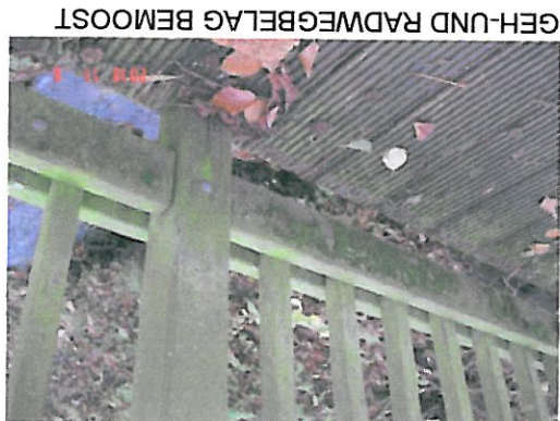
Beläge [8] Geh-und Radwegbelag, Holz, bereichsweise, bemoozt S=0, V=2, D=0
