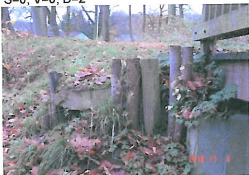
BÖSCHUNGSSICHERUNG SCHADHAFT
