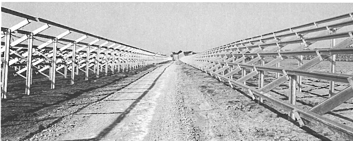
Abbildung 1: Systemdarstellung zur Aufständering der Gestelleinheiten (ohne Module)
