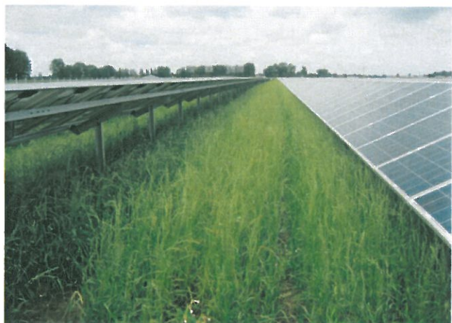
Bauweise einer Photovoltaikanlage
