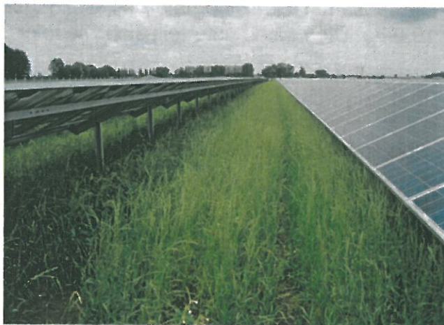
Bauweise einer Photovoltaikanlage
