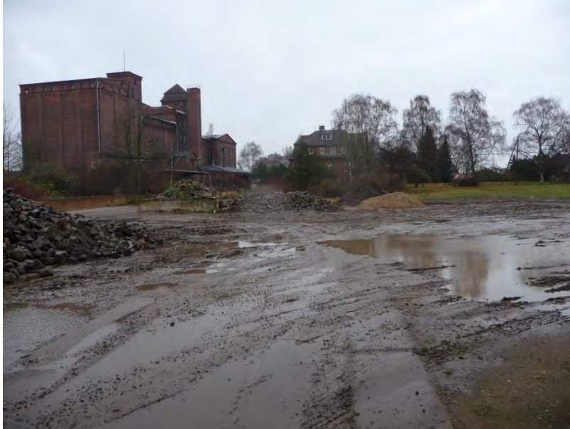
Abbildung 5: Bereich nördlich vom Silogebäude
