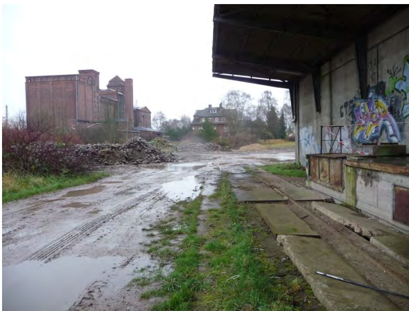
Abbildung 2: Blick in das Gelände mit Mühlengebäude
